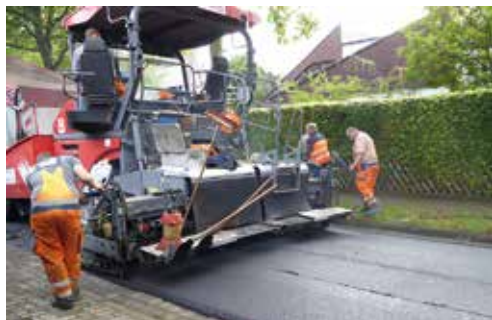
Mühlenstraße: Straßensanierung im August 2015
