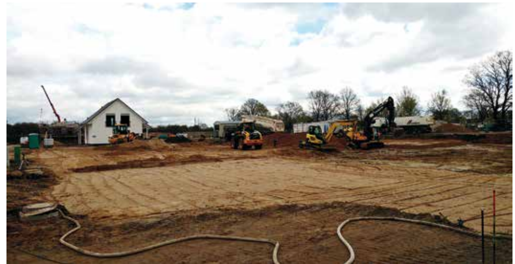
Bautätigkeiten im Neubaugebiet Bauernvogtskoppel
