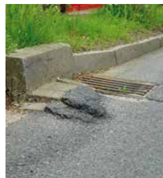
Asphaltaufruch Höppnerallee 56, gegenüber einer „Verkehrsnase“
