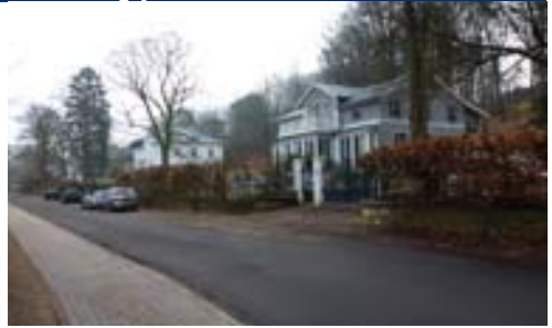
Zur Zeit wird die Straße Am Mühlenteich umfassend saniert.
