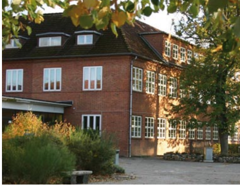
Die heutige Grundschule, seit Langem sanierungsbedürftig
