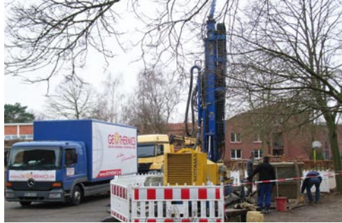
Auftragende Technik für die Erdwärmebohrung
