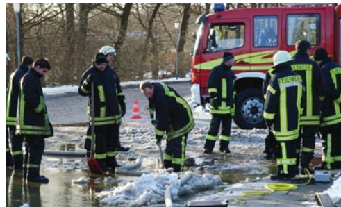
Feuerwehr sorgt für Nothilfe beim Rohrbruch
